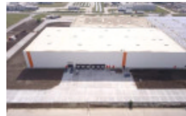
AQUILA ROMANIA In derulare EXTINDERE SPATII DEPOZITARE
