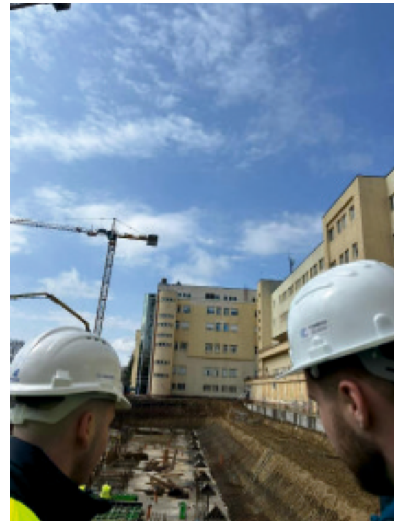
Spitalul Clinic de Urgenta Prof. Dr. Agrippa Ionescu - Lucrari de reabilitare, extindere, constructii
